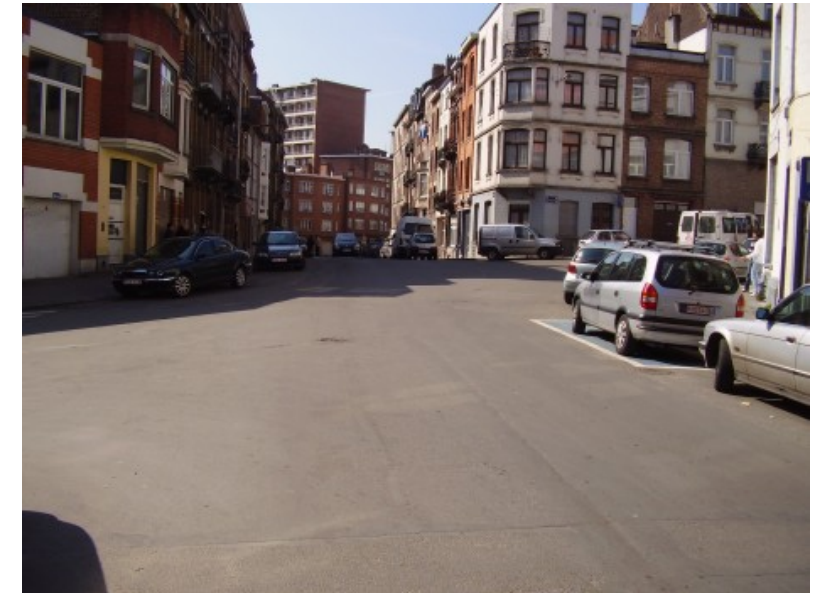
Kruispunt Houzeau de Lehaiestraat/Engelenbergstraat/Hovenierstraat: een uitgebreid voorplein van asfalt en een parkeren op de "hoeken" die geen goede waarneming van de plaats toelaat.
