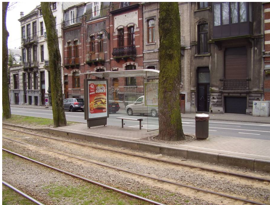
De toegang tot het wachthuisje (halte Besme) wordt gevaarlijk, en zelfs onmogelijk gemaakt, ten gevolge van de aanwezigheid van hinderpalen ( boomwortels en vuilnisbakken).
