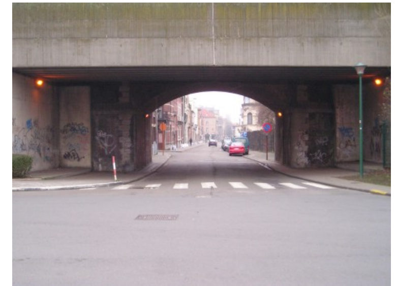
De Ganshorenstraat: een discrete doorgang onder de wegen door (spoorweg, metro), maar grote gevolgen voor het doorgaand verkeer (1.000 inkomende voertuigen/uur's ochtends).
