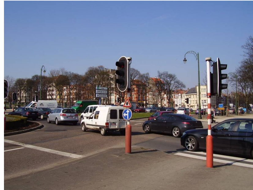
De uitrit "Basiliek" van de Leopold II-tunnel (knoop Bossaert) : een sleutelpunt van de mobiliteitsproblemen in Koekelberg.
