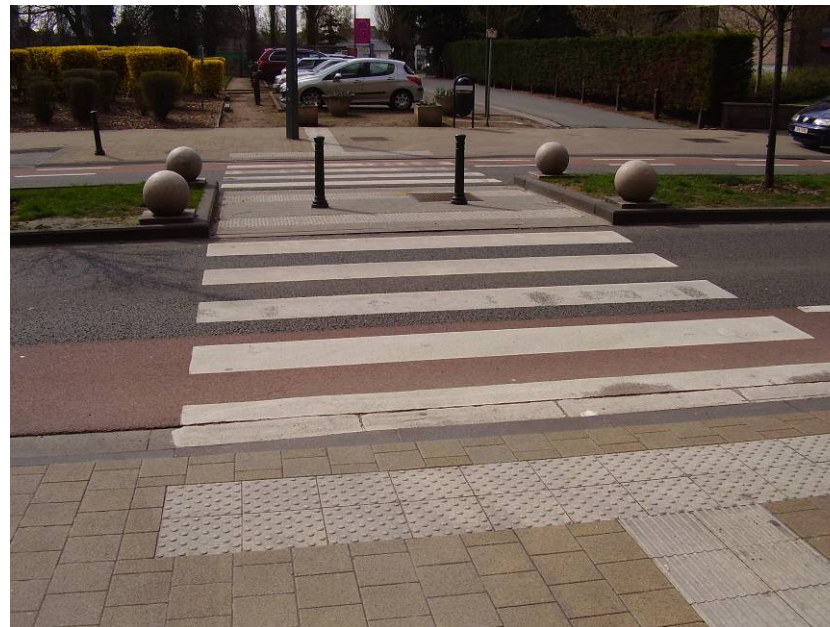
De onlangs opnieuw aangelegde voetpaden (hier Kasteellaan) zijn voorzien van noppentegels.
