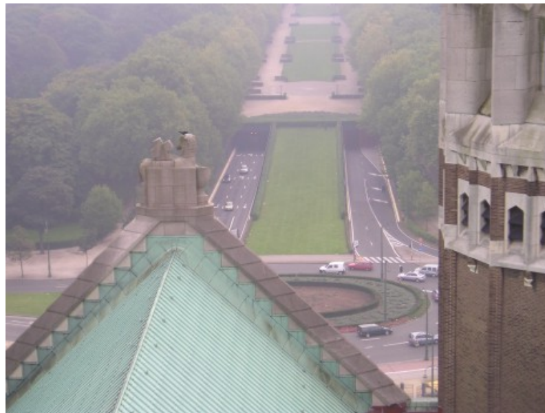
Toegang en uitrit "Basiliek" van de Leopold II-tunnel (Bossaertlaan): een punt van fundamentele overgang van het verkeer tussen een grote radiaalas en een grote ringvormige as.
