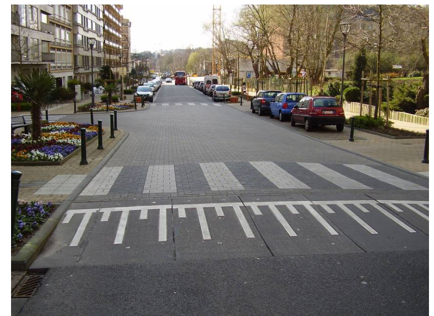
Het plateau op de Basiliëklaan is uit klinkers samengesteld, hetgeen deze beter doet opvallen en de snelheid van de automobilisten helpt te vertragen.
