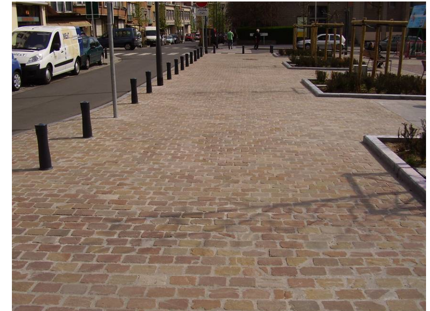
De voetpaden die de Van Huffelplaats afzomen, zijn gevormd door een bestrating in zandsteen, een sterk materiaal.
